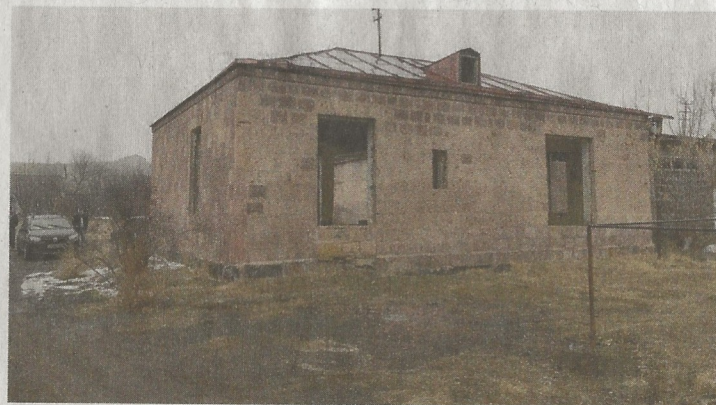
La futura sede del Centro diurno.
